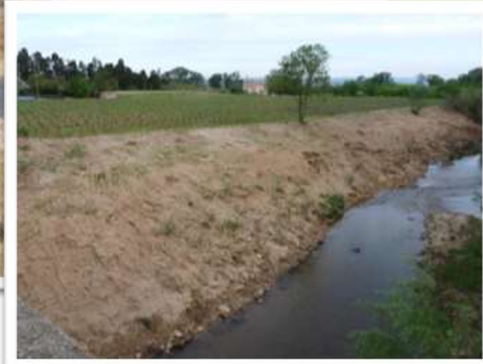
3 – Retalutage et enherbement
