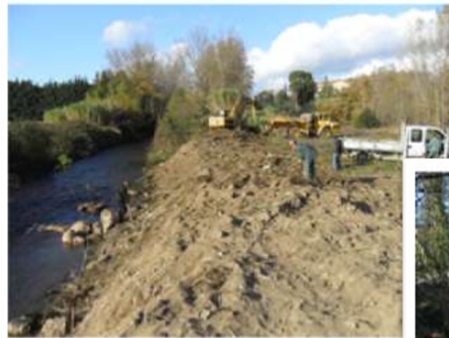
2 – Travaux en cours
