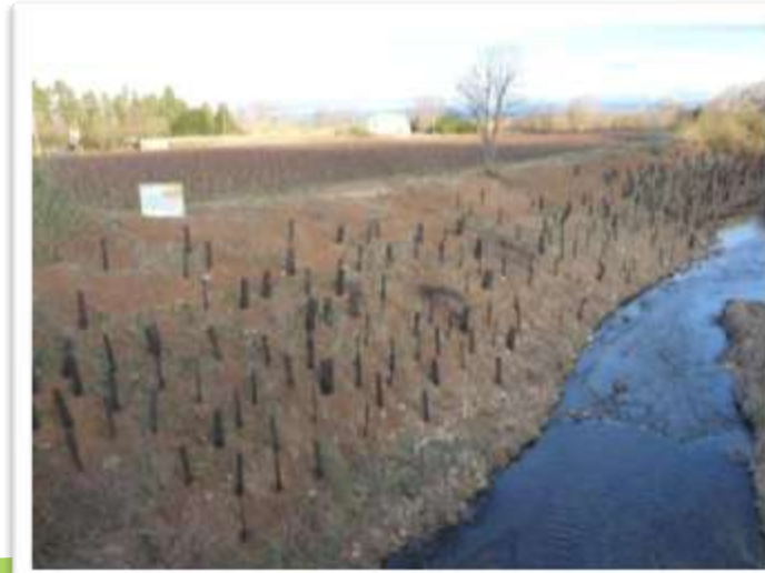
3 – Retalutage et enherbement
