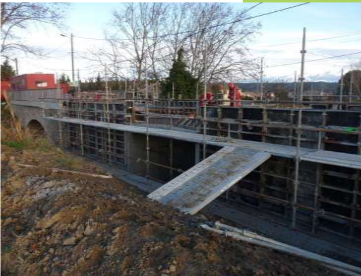
1 - Adjonction d'un ouvrage hydraulique (CG 11)
