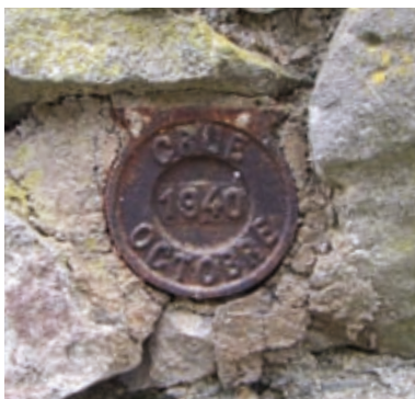
Repère de crue ancien
