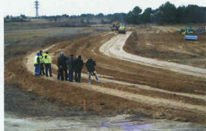
Chantier en cours
