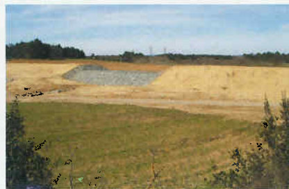
Digue, fin de chantier
